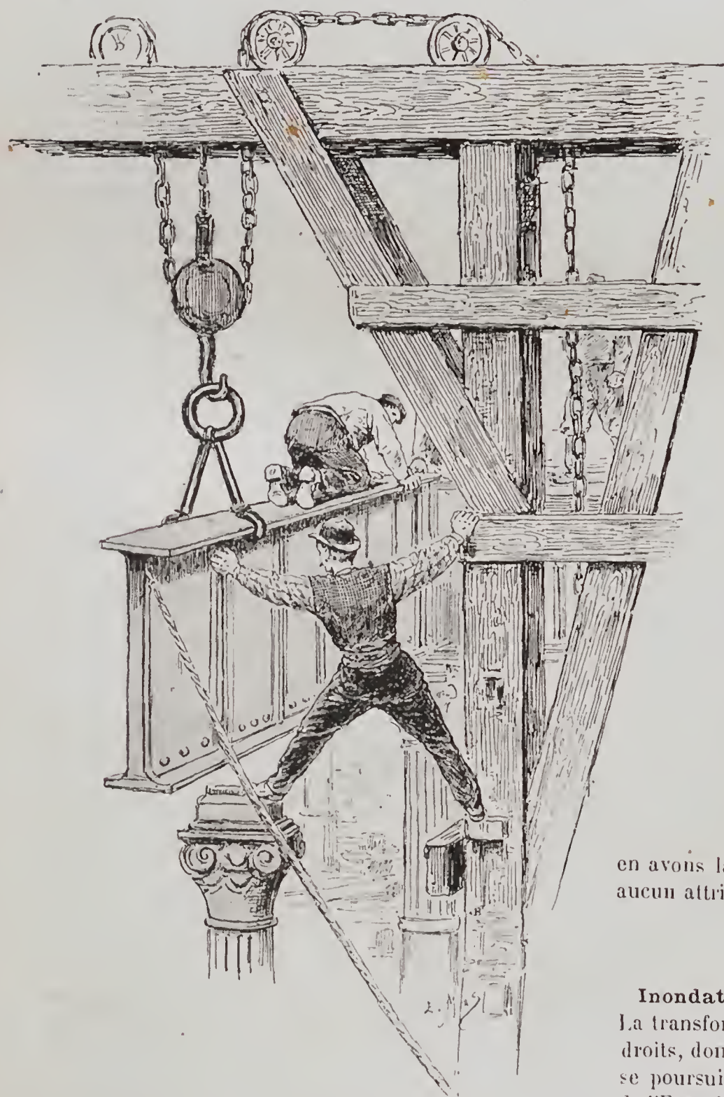
Mise en place d'une ferme droite.
